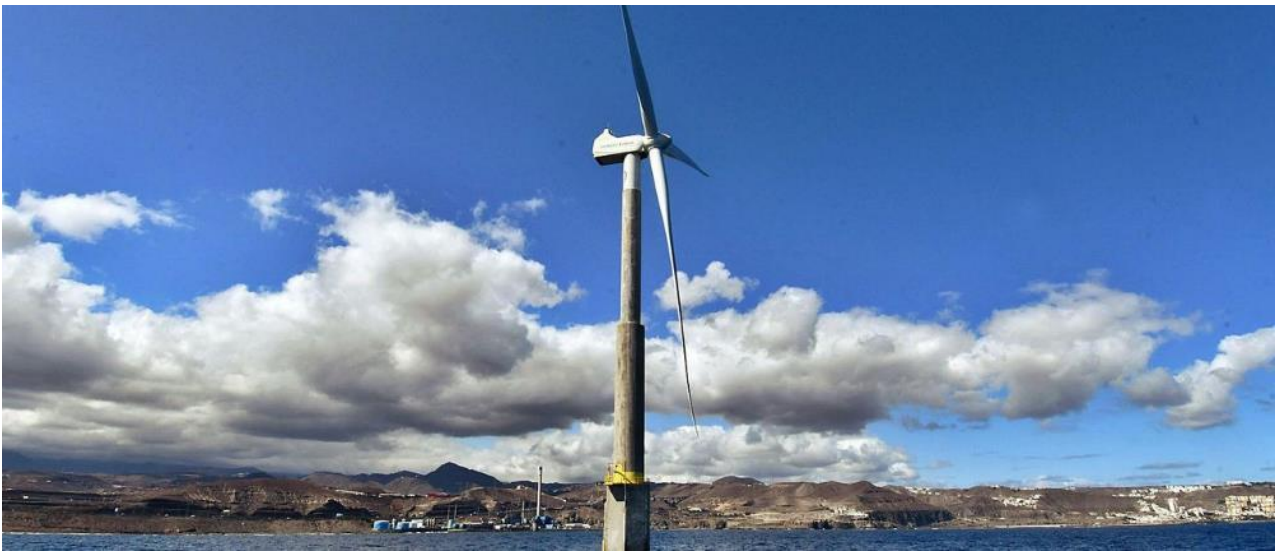
Figura 32: Proyecto ELISA de ESTEYCO, instalado en PLOCAN (Fuente: La Provincia. Autora: Yaiza Socorro).
