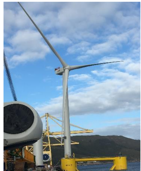
Figura 8: Aerogenerador con plataforma semi-sumergible, proyecto WindFloat (Fuente: Vestas).
