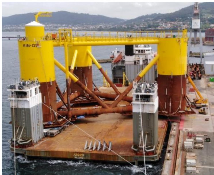
Figura 26: Construcción de una plataforma flotante en el Astillero de Fene, Ferrol 9 .
