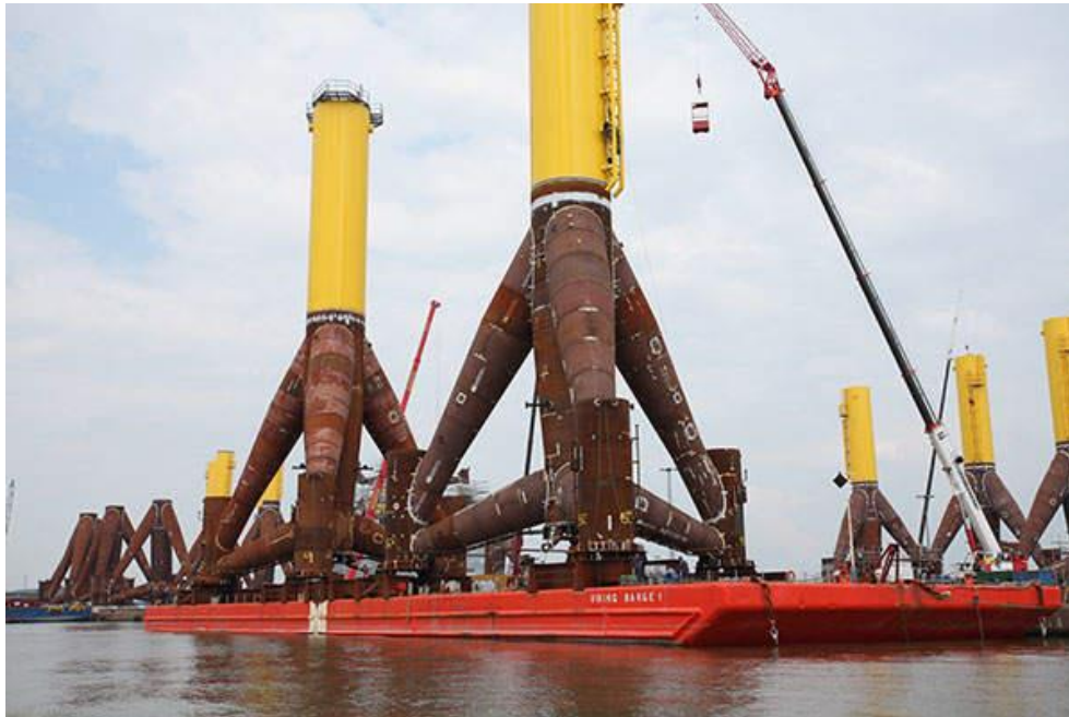
Figura 2: Cimentación fija trípode (Fuente: Power Technologies).
