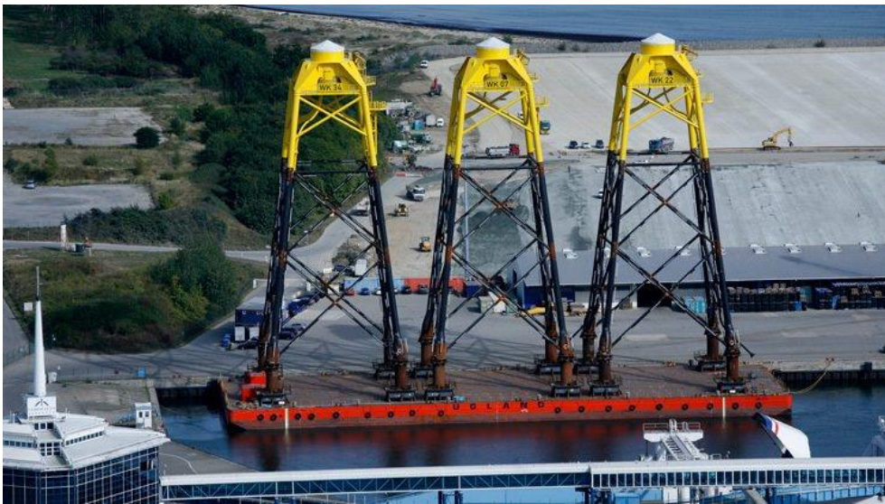
Figura 4: Cimentación fija tipo Jacket para el parque eólico marino de Wikinger, Alemania (Fuente: Iberdrola).
