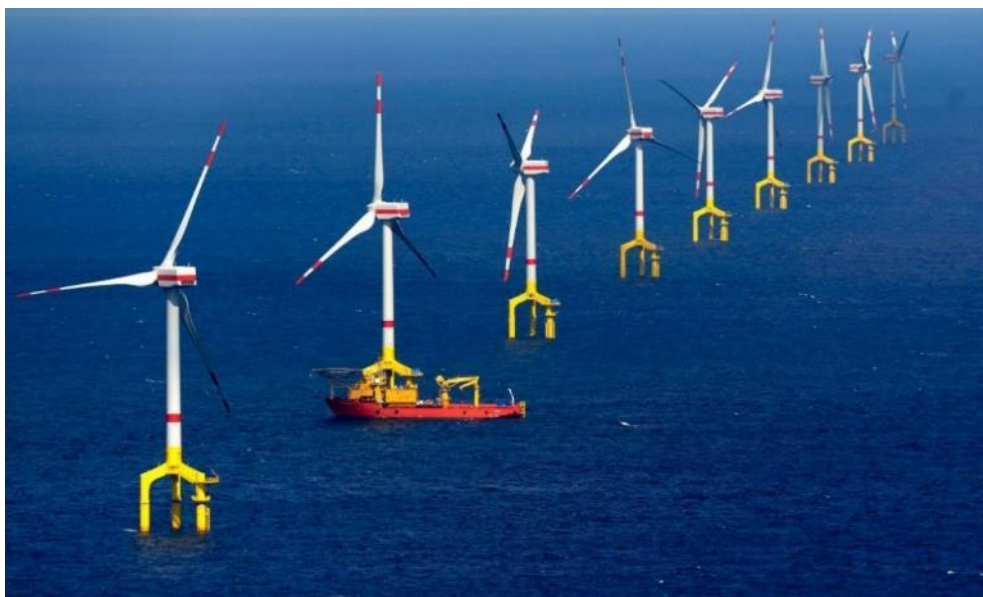
Figura 3: Aerogeneradores con cimentación fija tripile (Fuente: Fabian Bimmer/Reuters).
